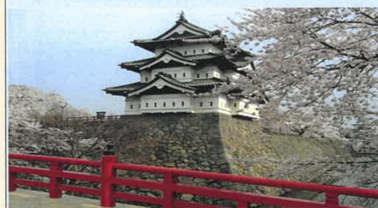
弘前城(天守曳家石垣解体前)【青森県】
